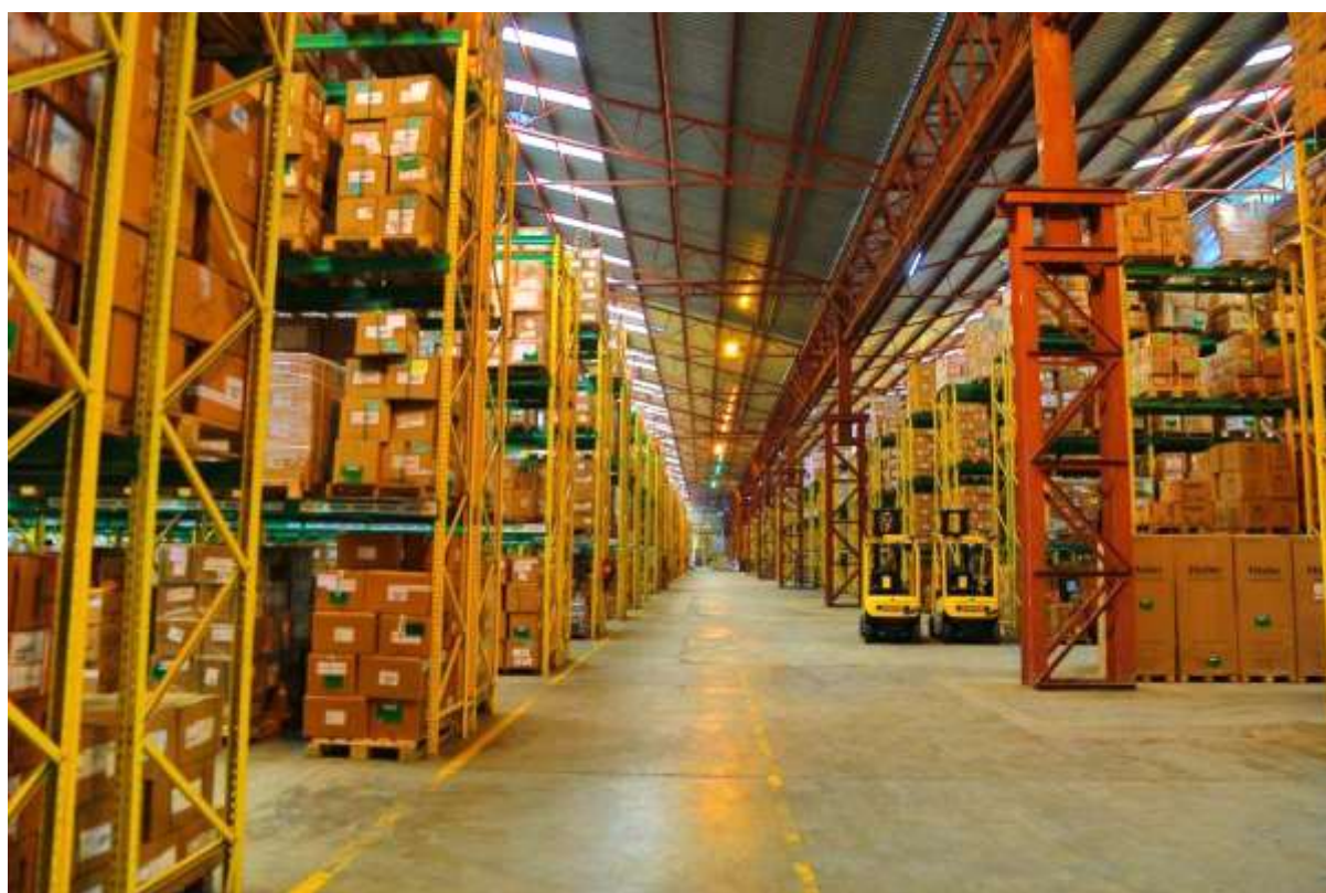
KEMSA Embakasi Warehouse
